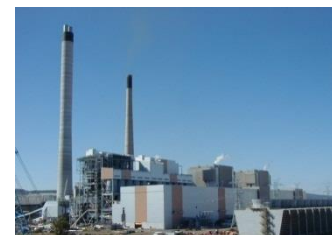
Callide SOVR Boiler 2 x 420 MW (2001)
