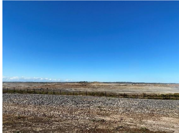
西シドニー空港建設予定地にて
